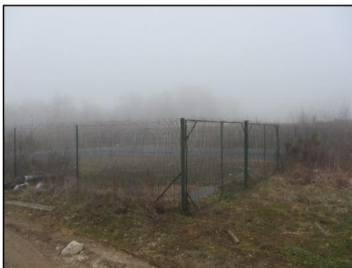
Fosse géomembrane sur le site de La Crouzette
