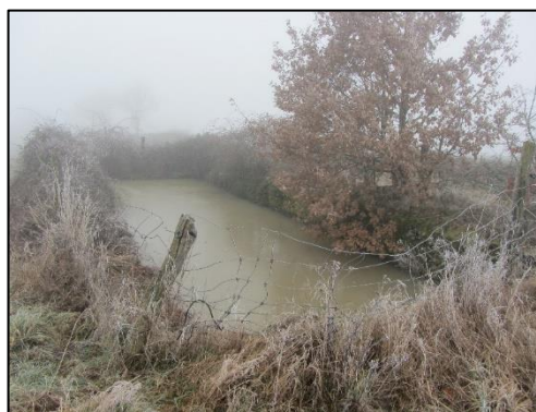
Citerne bâtie sur le site de La Bouyo Source : Artifex 2022
